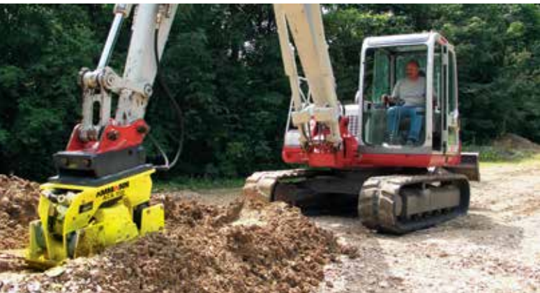
ACA 350 ohne Drehvorrichtung im Kanalbau
