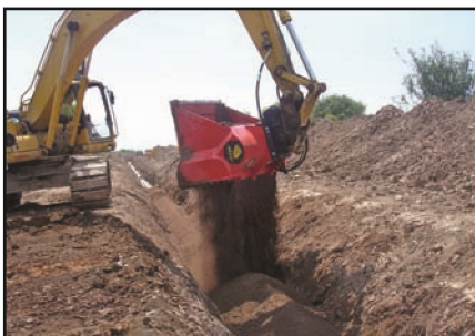
Kanalbau/Rückverfüllung
