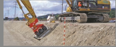
ALLU Verdichter Platte Hochleistungs-Verdichterplatte für extreme Arbeitsbereiche
