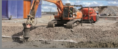
ALLU Stabilisierungssystem zum verfestigen unterschiedlicher Arten von weichem Material
