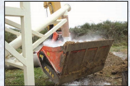
Stabilisieren von Boden mit Bindemittel
