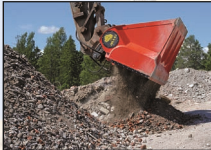
Brechen von Ziegeln und Asphalt
