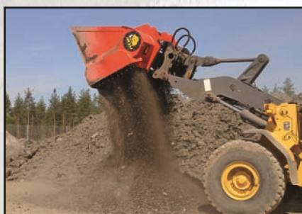
Belüften von kontaminiertem Bodenkompost
