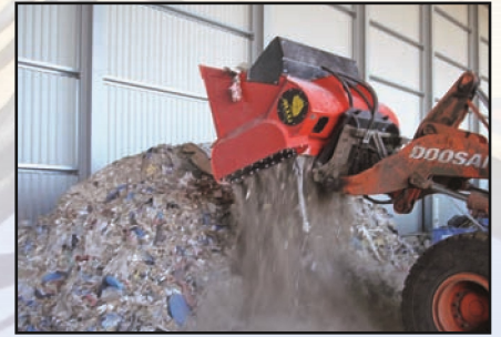
Brechen von Bauschutt
